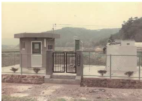
・創設時の松熊浄水場
