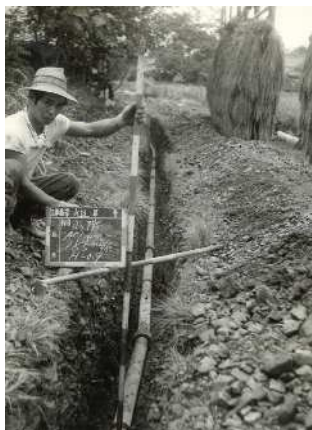
・配水管工事
