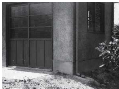
・旧法貴加圧ポンプ場
