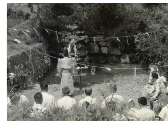
・創設当時の浄水場の地鎮祭
