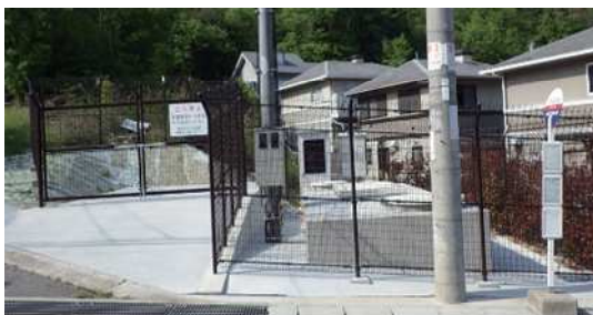
・高橋加圧ポンプ場
