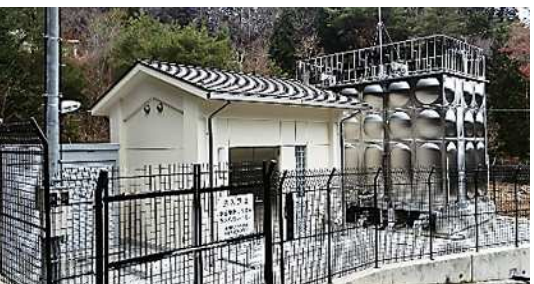
・広野配水池
