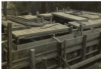
・創設時の今石配水池建設工事
