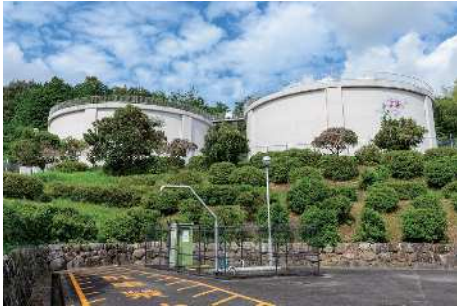
・湯井配水池（3号・4号）
