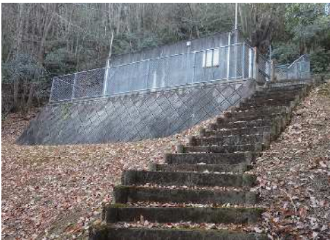
・下条配水池
