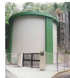
・旧高区配水池（統合整備時）
