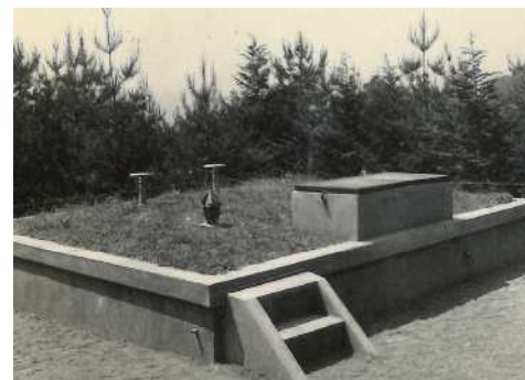
・旧国分配水池
