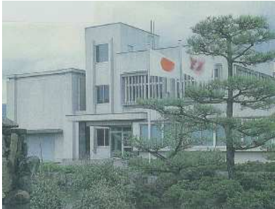
・千代川浄水場
