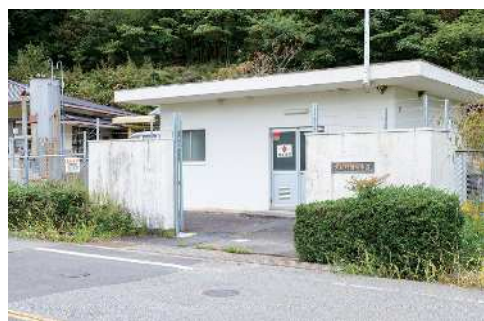
・現在の犬甘野浄水場
