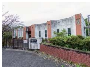
・南つつじヶ丘第1加圧ポンプ場
