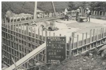
・旧青野配水池建設工事
