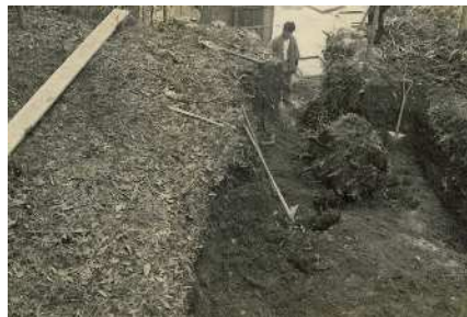
・創設時の今石浄水場建設工事
