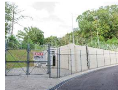
・西山配水池
