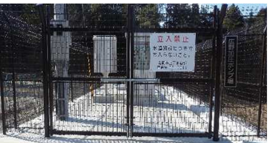
・広野加圧ポンプ場
