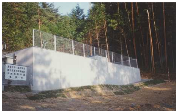
・千歳第2配水池
