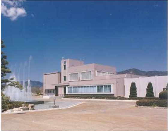
・千代川浄水場
