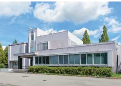
・千代川浄水場
