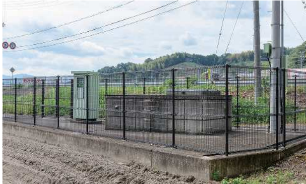
・千代川浄水場系取水井（9号）
