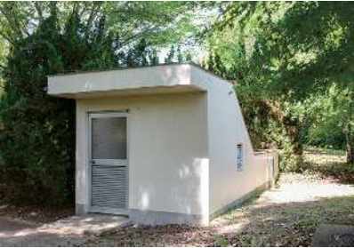
・千代川浄水場取水井戸
