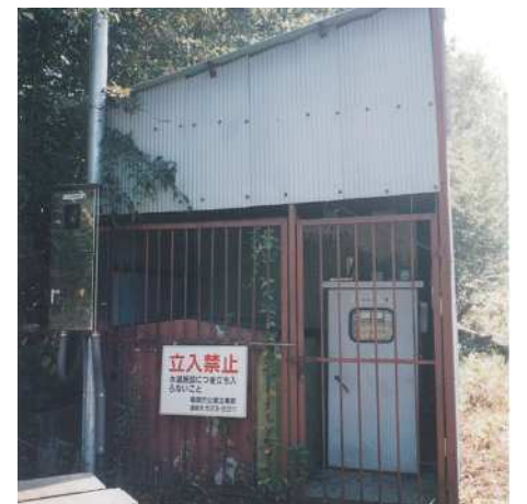
・旧西山第3加圧ポンプ場
