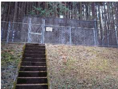
・柚原配水池
