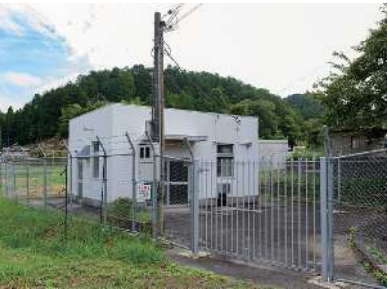
・柚原浄水場
