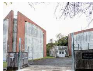
・南つつじヶ丘第2配水池
