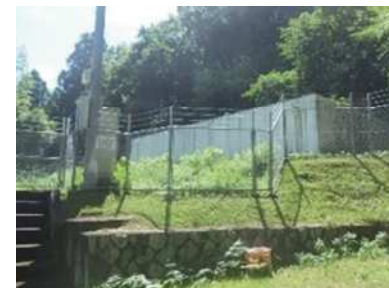
・湯の花調整池（旧湯の花配水池）
