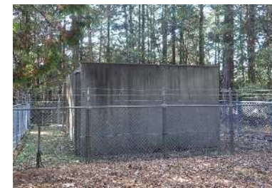
・百陀配水池
