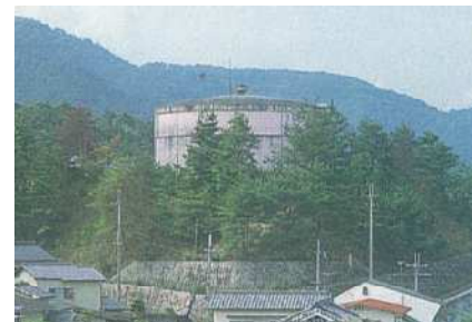
・旧西つつじヶ丘第1低区配水池 （令和2年撤去）
