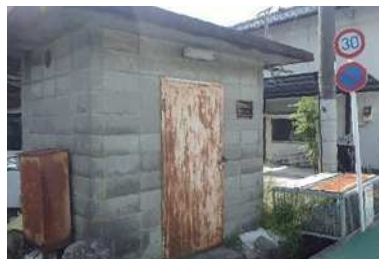
・旧王子加圧ポンプ場
