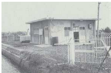
・創設当時の馬路浄水場
