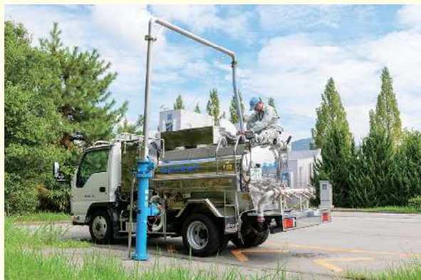
・千代川浄水場緊急給水栓
