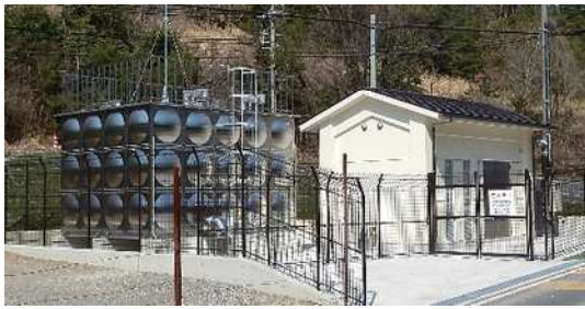
・西加舎第2加圧ポンプ場（本梅町）
