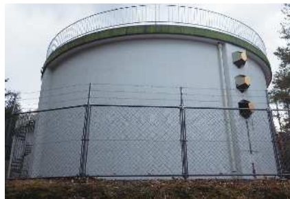
・湯の花配水池
