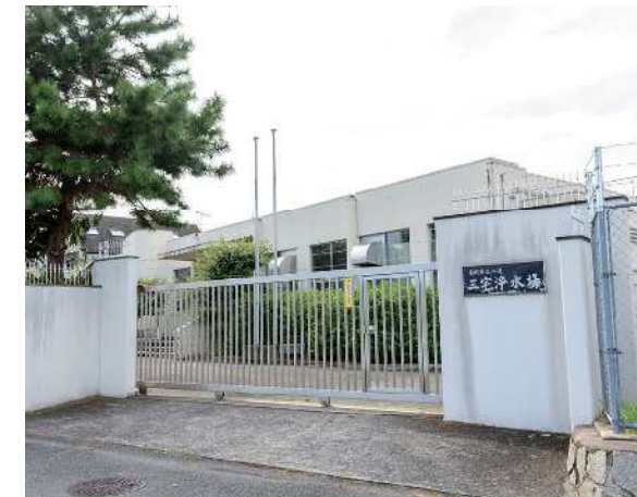
・三宅浄水場
