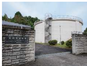
・南つつじヶ丘第1配水池
