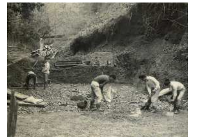
・創設時の浄水場建設工事（掘削）
