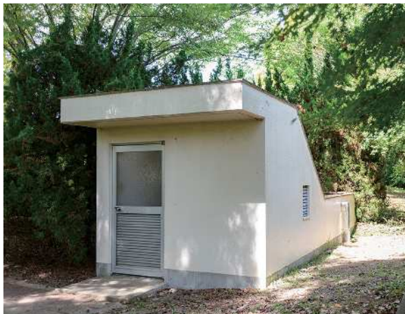
・千代川浄水場内2号取水井戸
