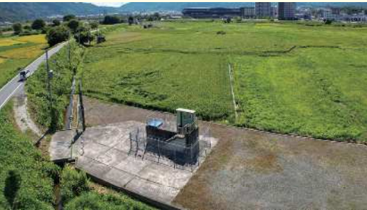
・三宅浄水場系水源5号井
