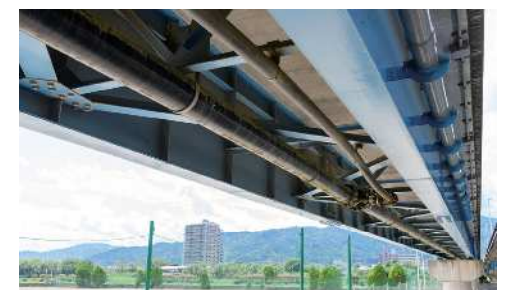
・月読橋下部φ200mm配水管
