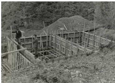
・旧美濃田浄水場建設工事
