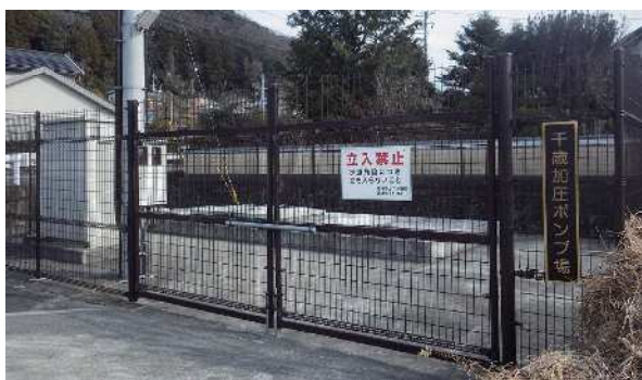
・千歳加圧ポンプ場
