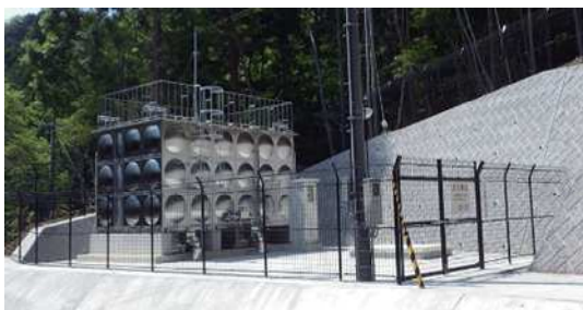
・土ヶ畑第2配水池
