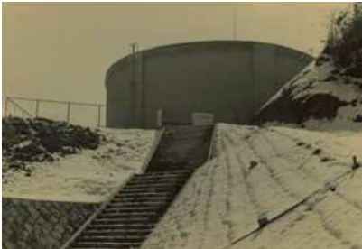
・西つつじヶ丘第1低区配水池
