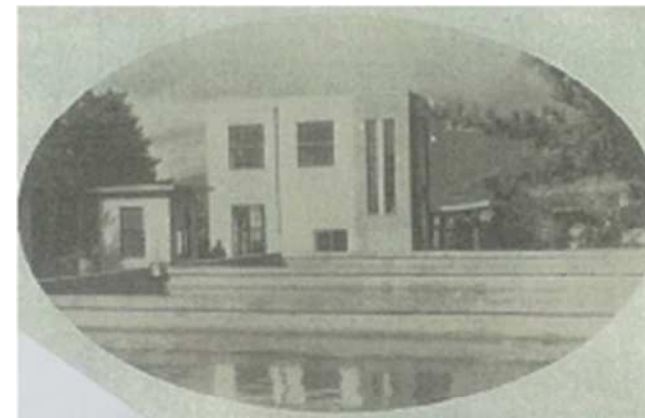
・旧春日坂浄水場
