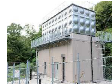
・王子配水池
