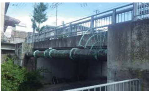
・平和台系配水幹線φ450mm 曙橋水管橋
