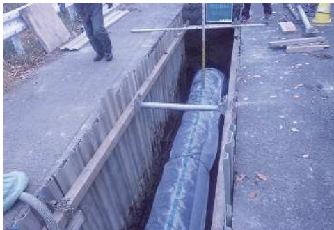
・京都縦貫道側道での連絡管工事 湯井配水池～平和台配水池（φ600mm）
