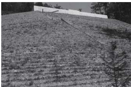
・創設当時の重利低区配水池
