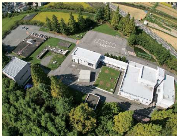
・千代川浄水場
