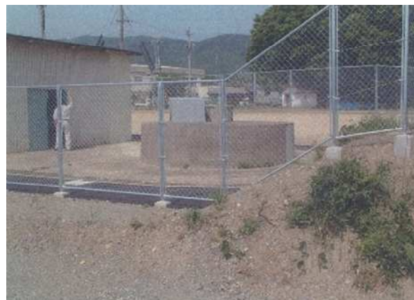
・旧河原林浄水場・取水井戸（簡易水道統合時）
