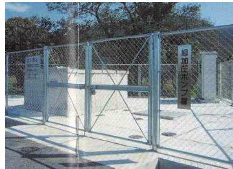
・旭加圧ポンプ場
