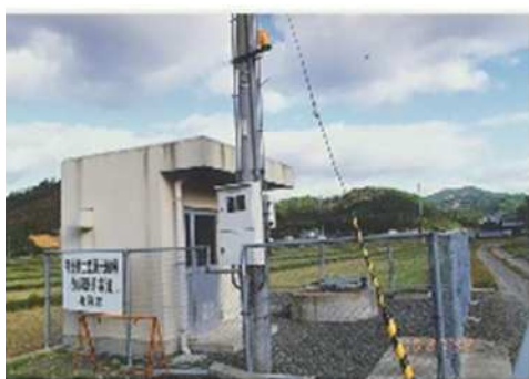
・旧赤熊浄水場、取水井戸
