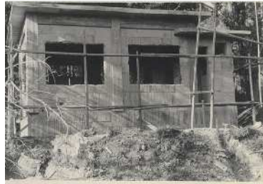
・井手浄水場建設工事（現在は井手加圧ポンプ場）
