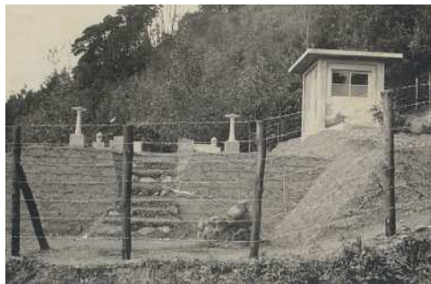
・旧山本浄水場全景
