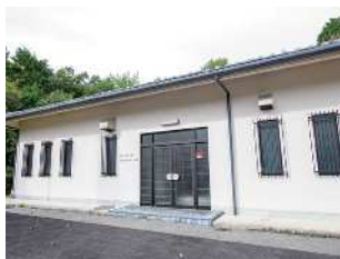
・南つつじヶ丘第2加圧ポンプ場
