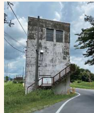
【保津水源】 ポンプ室
