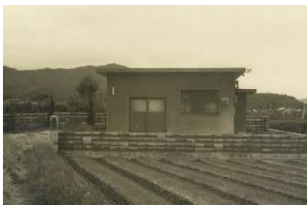
・創設当時の重利浄水場
