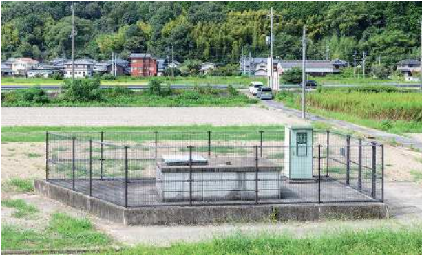
・千代川浄水場系取水井（8号）
