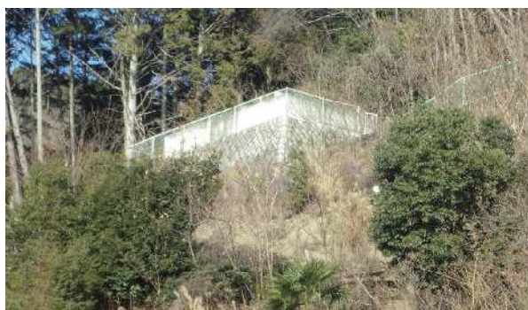
・千歳第1配水池
