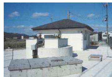
・旧馬路浄水場（簡易水道統合時）
