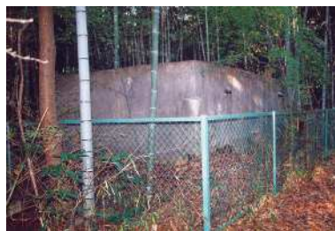
・旧王子配水池
