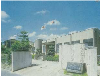
・三宅浄水場
