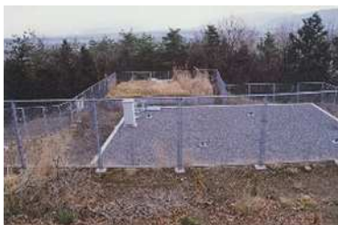
・旧馬路配水池（昭和63年拡張時）
