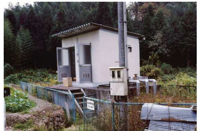
・旧西山第1加圧ポンプ場
