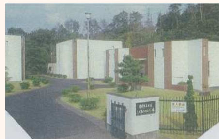
【南つつじヶ丘第1配水池】
