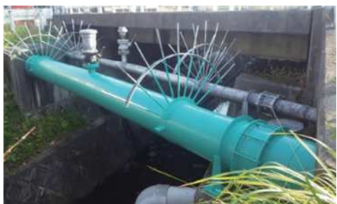
・平和台系配水幹線φ450mm 平塚橋水管橋
