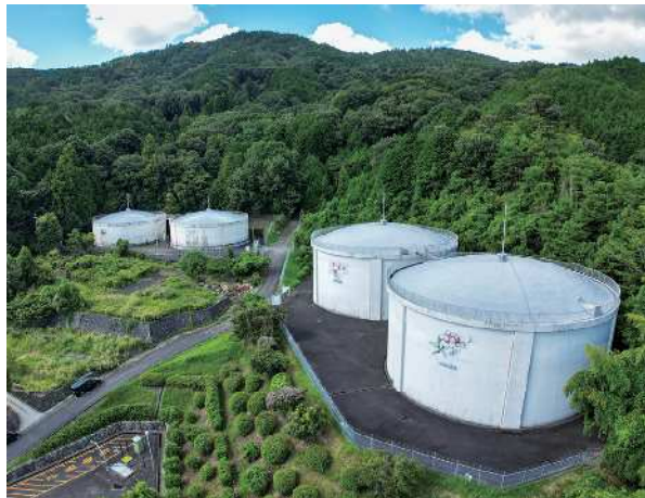
・湯井配水地
