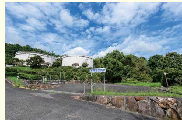
・緊急給水拠点（湯井配水池）
