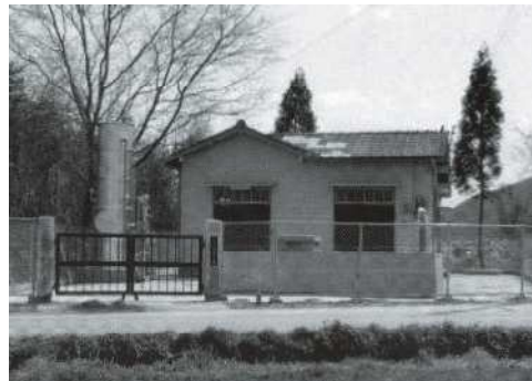
・旧天川浄水場全景（昭和47年施設拡張時）
