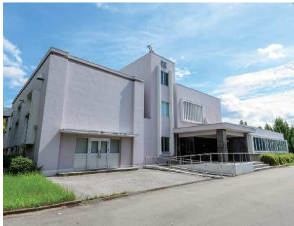
・千代川浄水場
