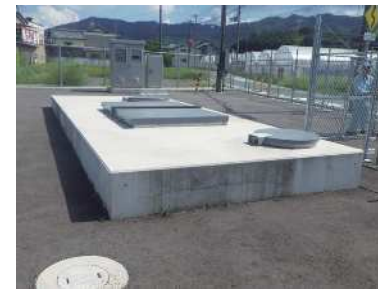
・王子加圧ポンプ場
