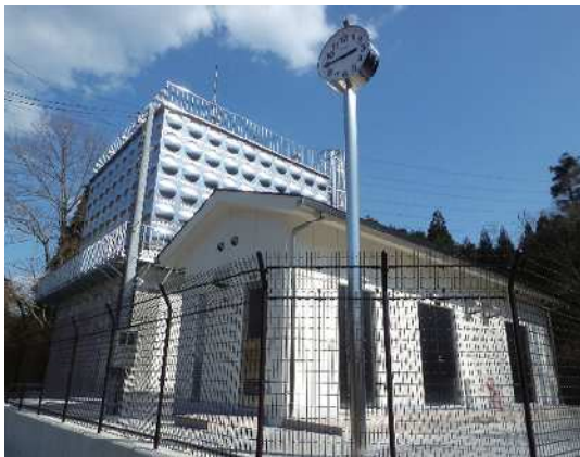
・千ヶ畑第1配水池
