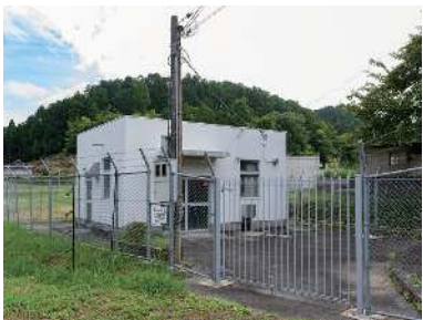
・柚原浄水場
