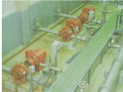
・千代川浄水場送水ポンプ室
