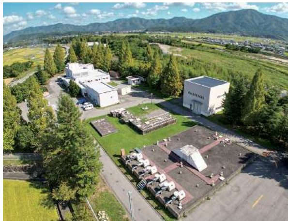
・千代川浄水場全景
