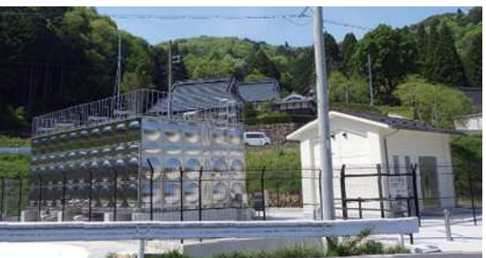
・土ヶ畑第1配水池 土ヶ畑第2加圧ポンプ場
