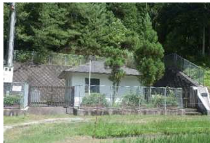
・湯の花加圧ポンプ場
