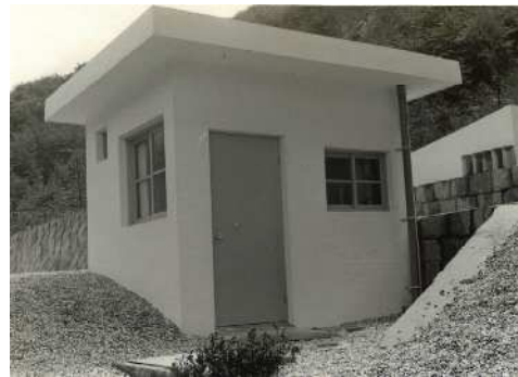
・旧ろ過調整滅菌室
