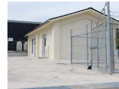
・篠加圧ポンプ場
