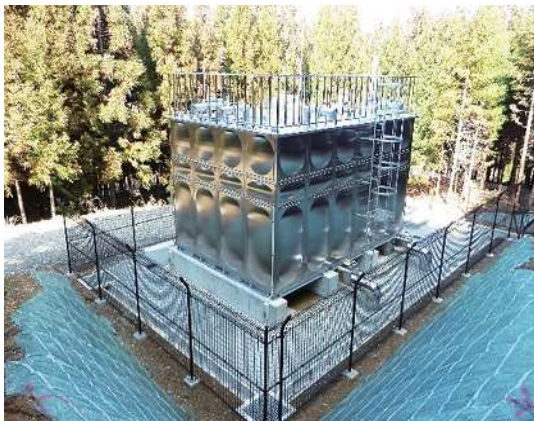
・千ヶ畑第2配水池
