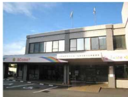
亀岡市保健センター内 1階
