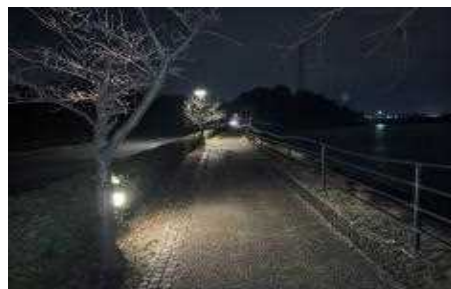
水鳥の道整備 (照明設備)
