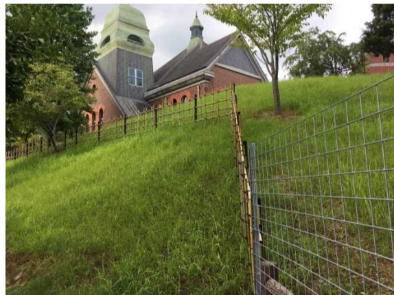
薬草原 獣害柵設置
