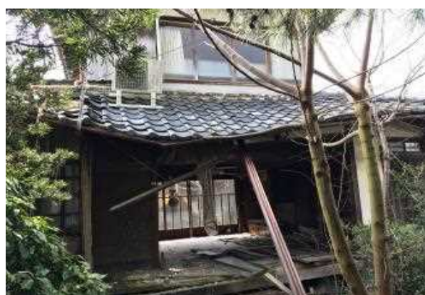
工事前(築96年の古民家)
