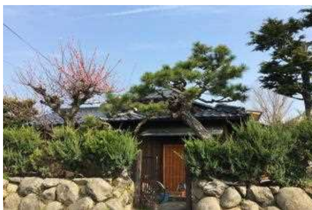
工事後(移住促進拠点「離れにのうみ」)
