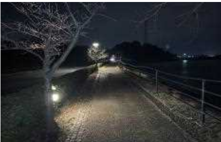
水鳥の道整備 (照明設備)
