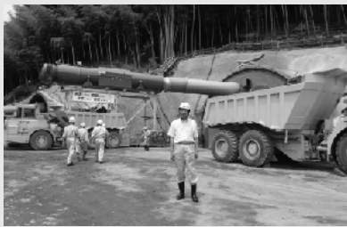
にそと(京都第二外環状道路)工事現場
