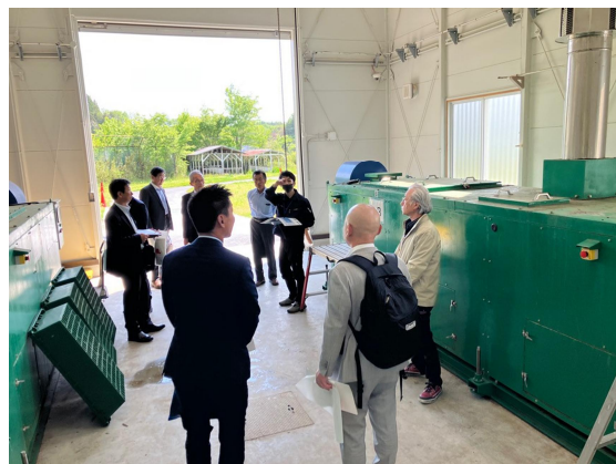
減容化処理施設内 様子
