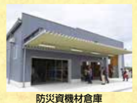
防災資機材倉庫
