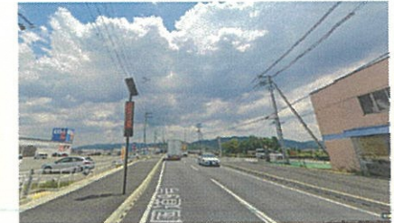
整備後の状況(令和6年)
