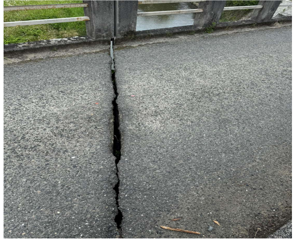
劣化・亀裂が著しい
