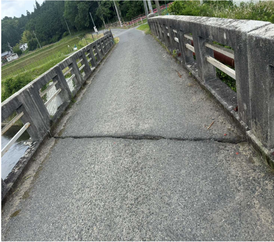
劣化・亀裂が著しい
