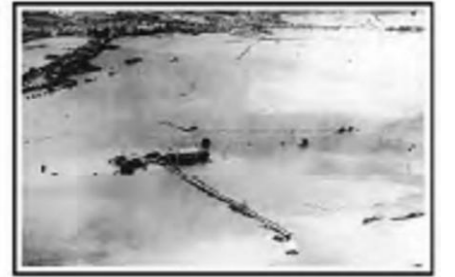
S35 被災状況写真
