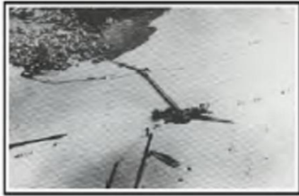
S28 被災状況写真
