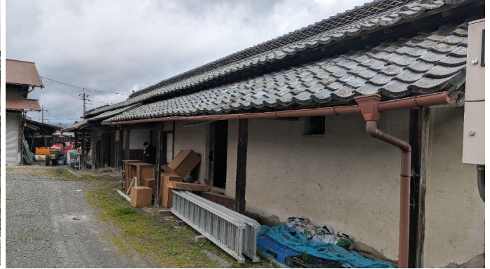
長屋門外観（裏から）
