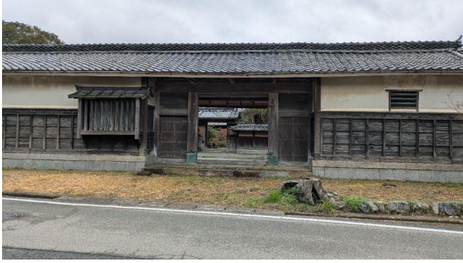
長屋門外観（正面から）
