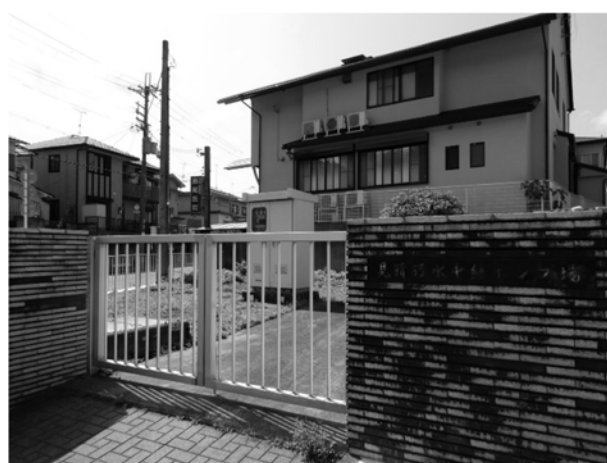
●見晴汚水中継ポンプ場
