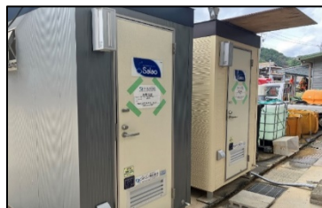
快適トイレ（珠洲市）
