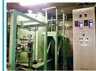
次亜塩素酸ソーダ貯留タンクNo.1 (R5~R6) 経過年数:H10年(25年経過) 概要:貯留タンク・配管他更新 能力:6.0m 3
