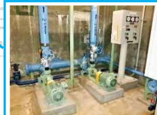
ろ過水ポンプNo.1、2 (R5~R6) 経過年数:H17(18年経過) 概要:ろ過水ポンプNo.1、2他改築 能力:No.1、2 共 0.4m 3 /min(5.5kW)
