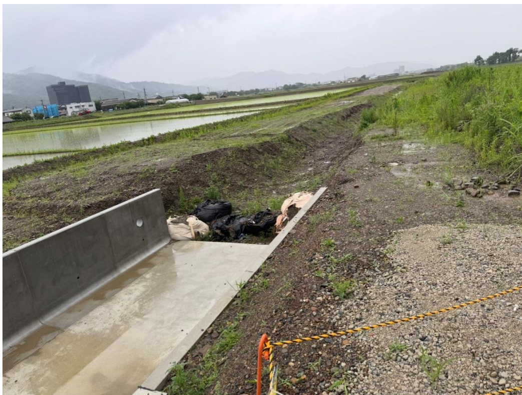
桂川西工区 雨水排水路
