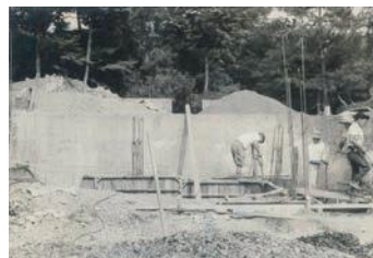
旧保津ヶ丘浄水場建設工事
