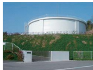
平和台配水池
