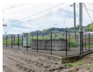
千代川浄水場 取水施設
