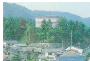
旧西つじヶ丘第1低区配水池
