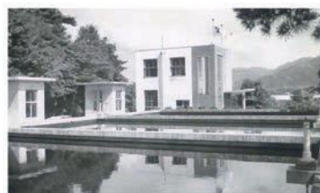
旧春日坂浄水場(北古世町)
