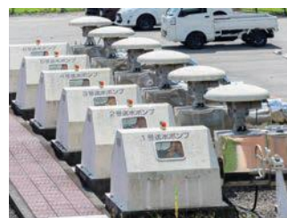
浄水池・送水ポンプ井
