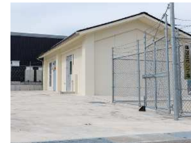
・篠加圧ポンプ場
