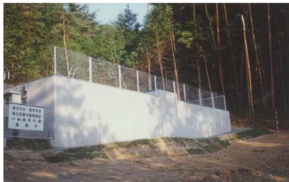
・千歳第2配水池
