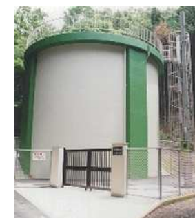
・旧高区配水池（統合整備時）
