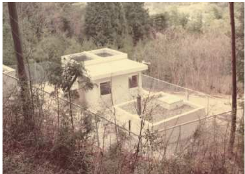
・小泉浄水場、ろ過池
