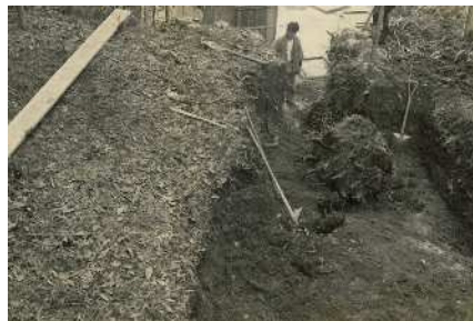
・創設時の今石浄水場建設工事
