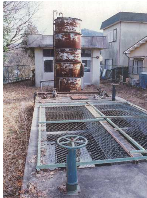
・旧西山浄水場
