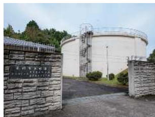
・南つつじヶ丘第1配水池
