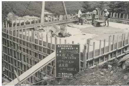
・旧青野配水池建設工事
