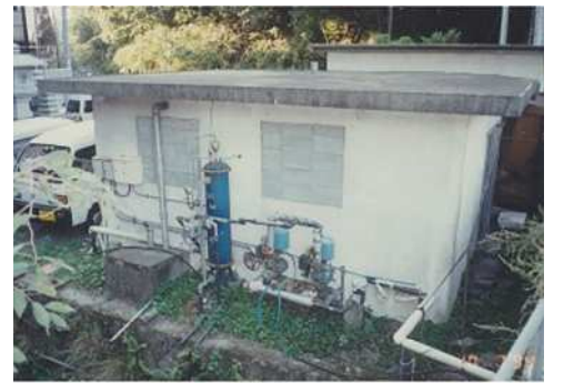
・旧湯の花浄水場
