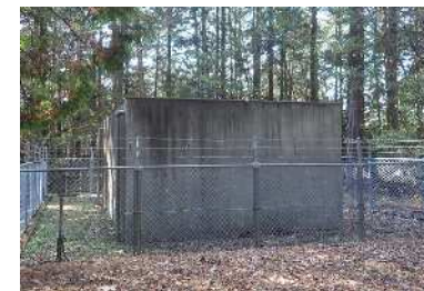
・百陀配水池
