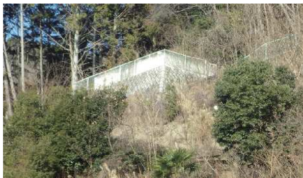
・千歳第1配水池
