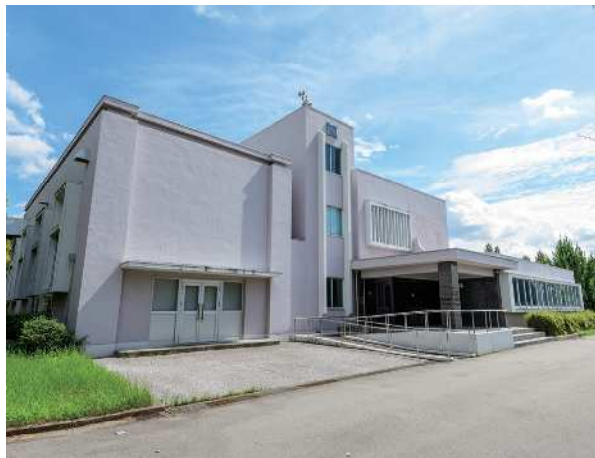
・千代川浄水場
