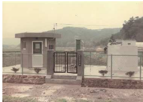
・創設時の松熊浄水場
