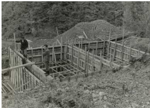
・旧美濃田浄水場建設工事
