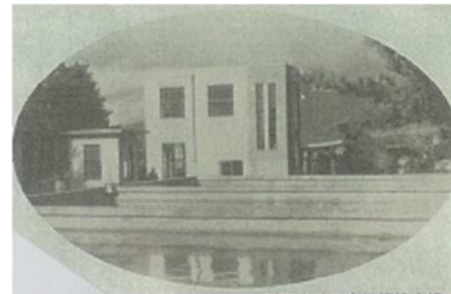
・旧春日坂浄水場
