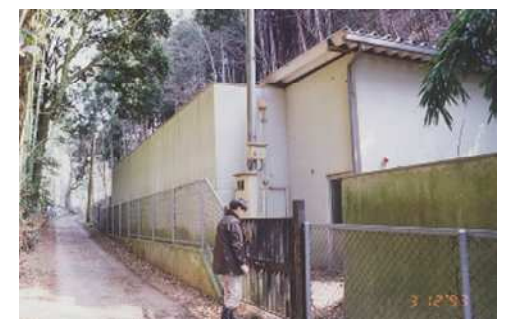
・旧低区配水池（統合整備時）
