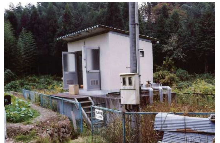
・旧西山第1加圧ポンプ場
