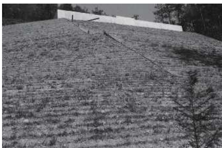
・創設当時の重利低区配水池
