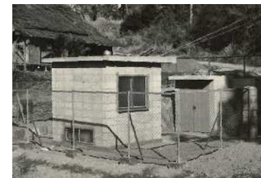
・創設時の百陀浄水場
