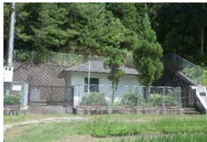
・湯の花加圧ポンプ場
