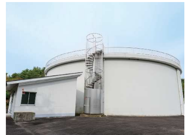
・平和台配水池
