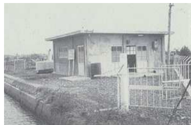
・創設当時の馬路浄水場
