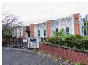
・南つつじヶ丘第1加圧ポンプ場
