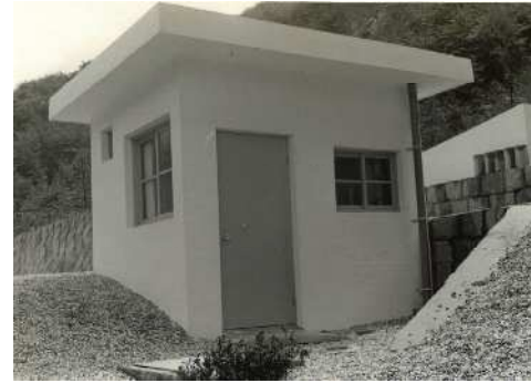
・旧ろ過調整滅菌室
