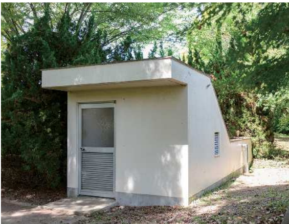
・千代川浄水場内2号取水井戸
