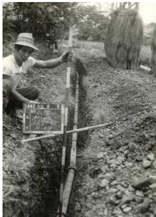
・配水管工事
