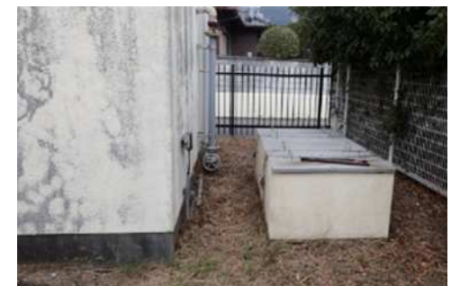
・旧第1取水井戸（統合整備時）
