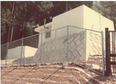
・小泉浄水場、配水池
