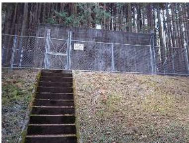
・柚原配水池
