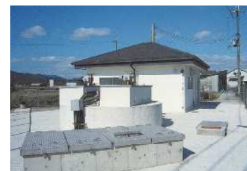
・旧馬路浄水場（簡易水道統合時）
