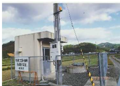
・旧赤熊浄水場、取水井戸
