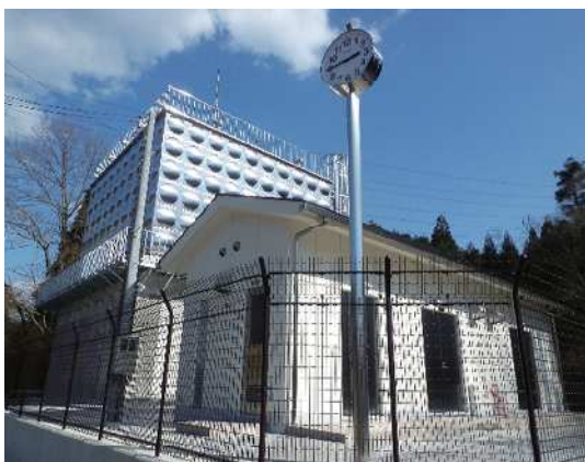
・千ヶ畑第1配水池
