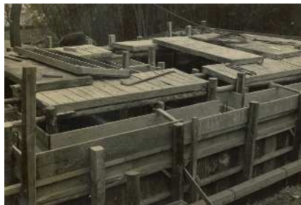
・創設時の今石配水池建設工事
