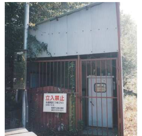
・旧西山第3加圧ポンプ場
