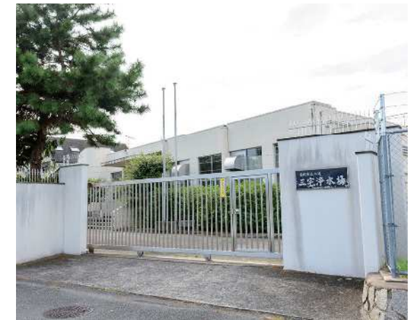
・三宅浄水場
