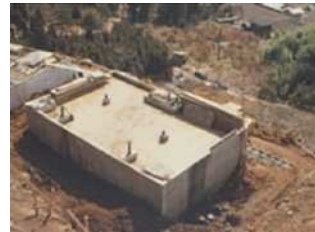
・増設配水池（昭和54（1979）年）
