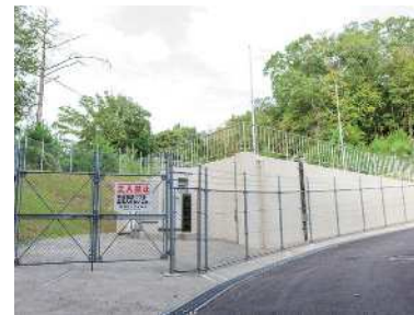
・西山配水池
