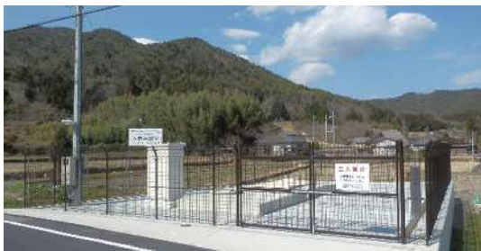
・西加舎第1加圧ポンプ場（本梅町）
