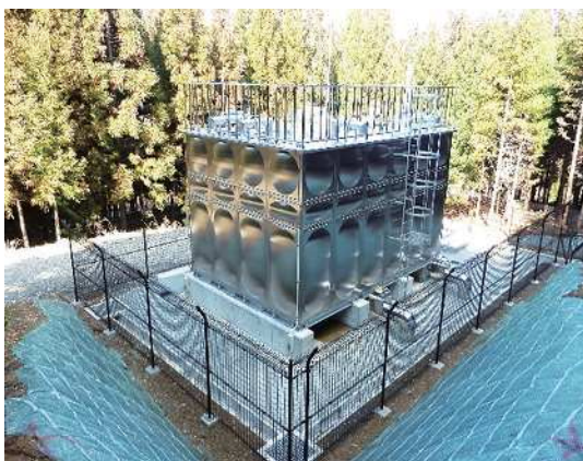
・千ヶ畑第2配水池
