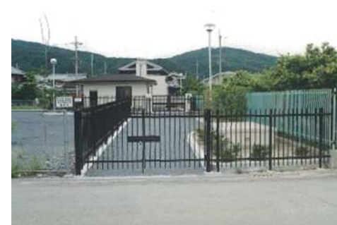
・旧第2取水井戸（統合整備時）
