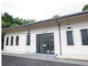
・南つつじヶ丘第2加圧ポンプ場
