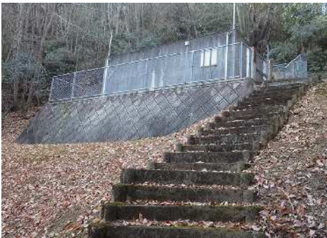
・下条配水池
