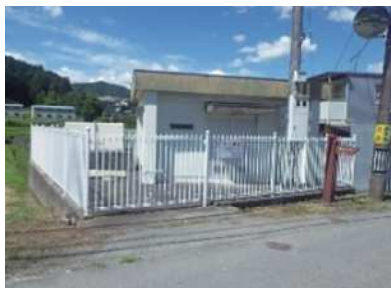
・佐伯加圧ポンプ場
