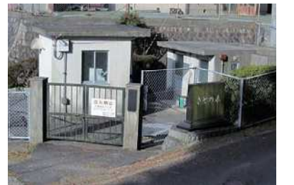
・現在の百陀浄水場
