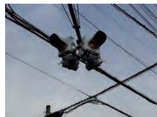
市道河原町余部線路上に設置の点滅信号
