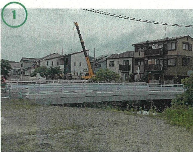
現況写真 国道9号 千々川橋から下流
