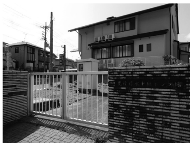
●見晴汚水中継ポンプ場
