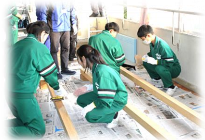
生徒会本部による窓枠塗装の様子
