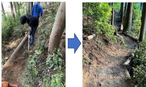
遊歩道の整備
