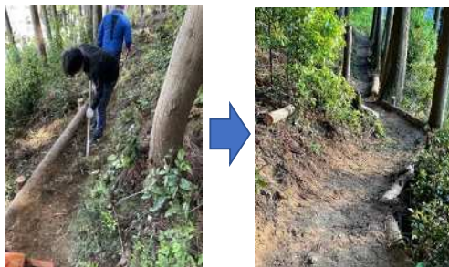
遊歩道の整備
