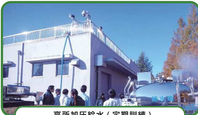
高所加圧給水 (定期訓練)
