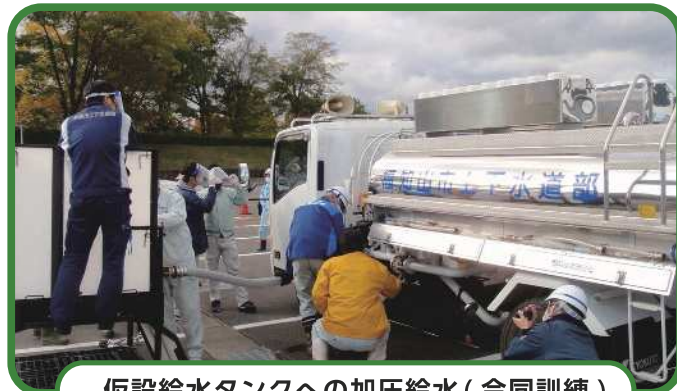
仮設給水タンクへの加圧給水 (合同訓練)
