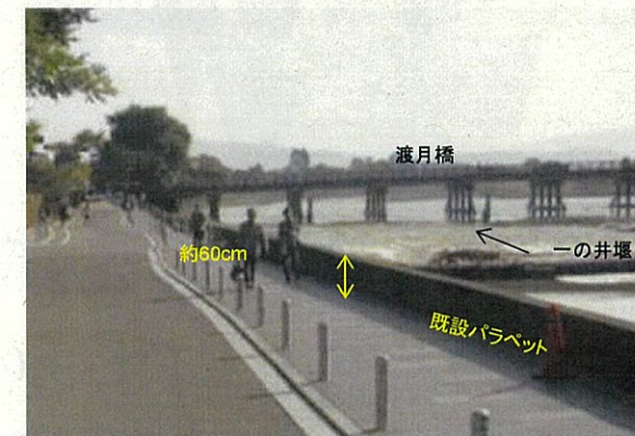
一の井堰上流には既存のパラペットが存在
