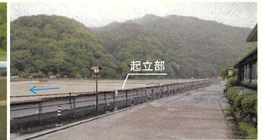
現地状況（起立部）
