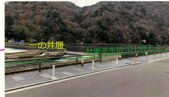
一の井堰下流は計画高水位より地盤高は低い
