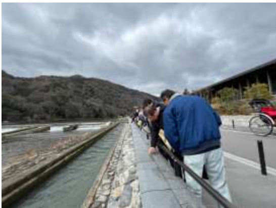
嵐山現地調査（可動式止水壁）
