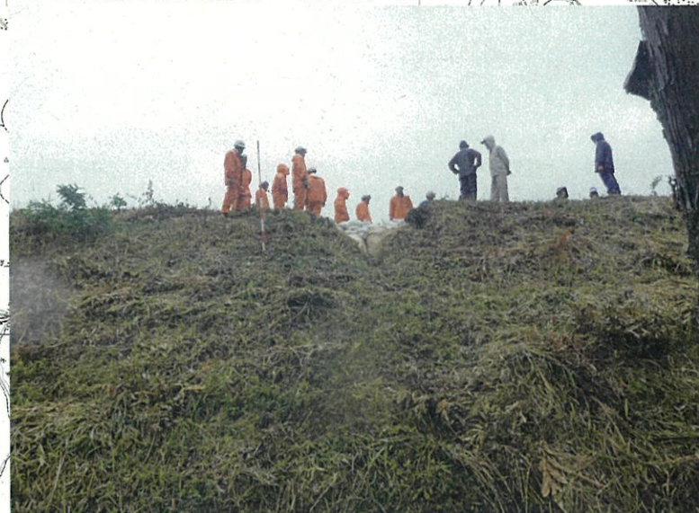
ため池堤体法面崩壊 菟田野町
