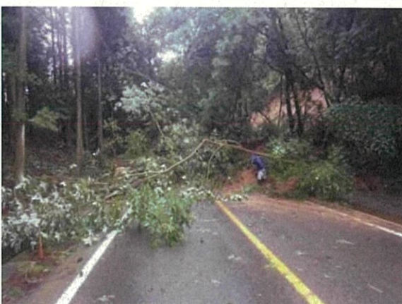
㉔ 423 国道423号 【通行止】 亀岡市西別院町笑路 (大規模崩土)
