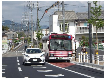
市道改良工事に伴いバスの停車スペースの確保と置石埋設を実施(都台バス停)
