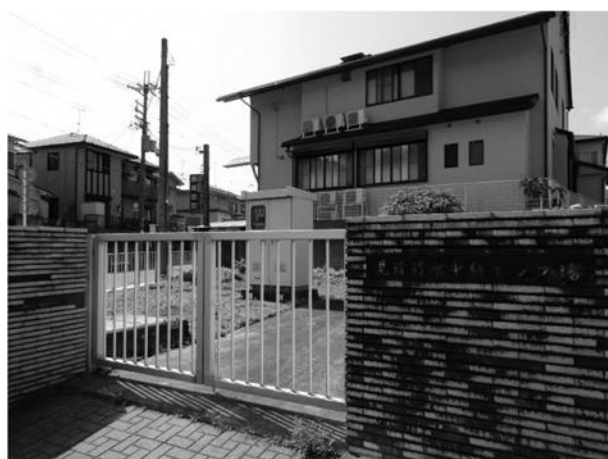
● 見晴汚水中継ポンプ場
