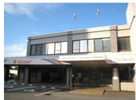
亀岡市保健センター内 1階
