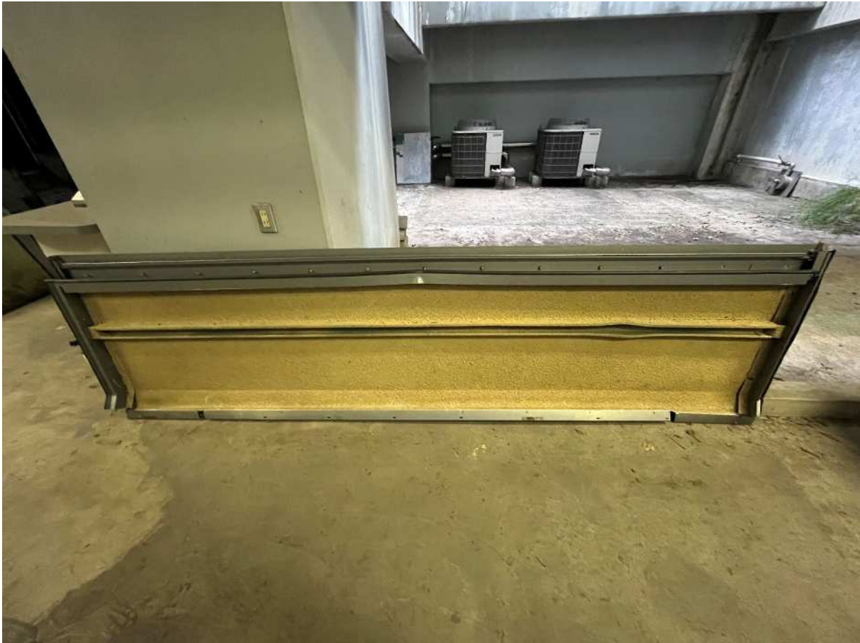
破損したパネル（材質アルミニウム、L=3.2m×W=0.82m）
