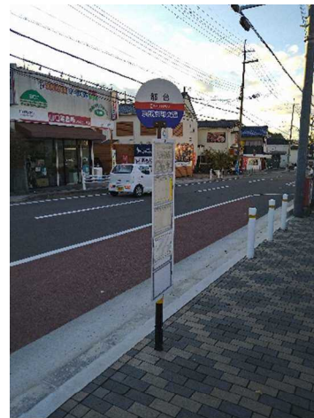
市道改良工事に伴いバスの停車スペースの確保と置石埋設を実施(都台バス停)
