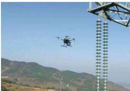
写真 2.1.1 ドローンによる赤外線撮影例
