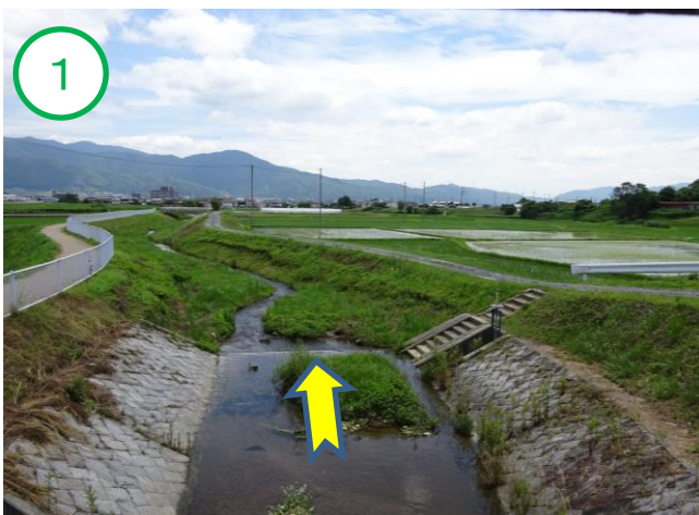
整備完成写真 千々川側道3号線 井根口橋から下流
