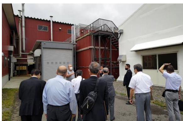
発酵したガスの処理施設を見学
