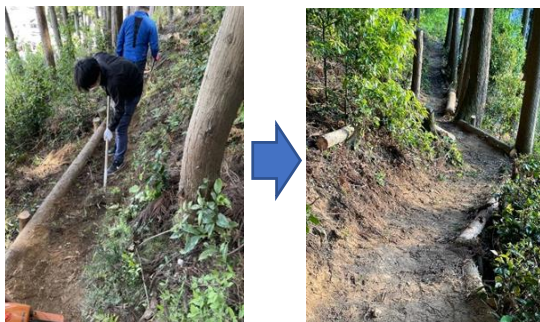
遊歩道の整備
