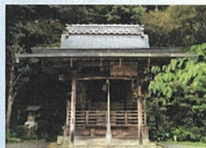
池尻天満宮 本殿
