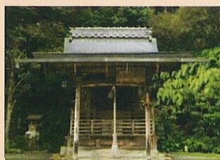
池尻天満宮 本殿
