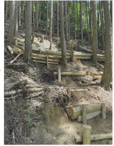
遊歩道の整備
