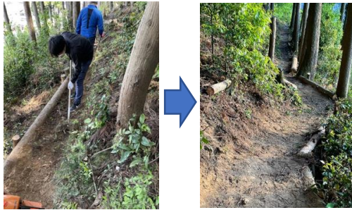
遊歩道の整備
