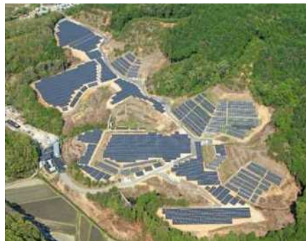
京都・亀岡メガソーラー発電所
