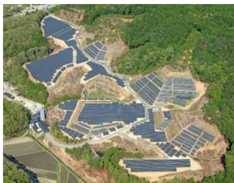
京都・亀岡メガソーラー発電所
