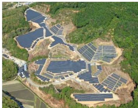
京都・亀岡メガソーラー発電所
