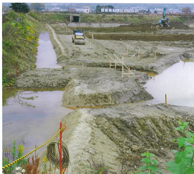
亀岡駅北口から道路沿いに北を見る
