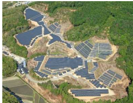
京都・亀岡メガソーラー発電所
