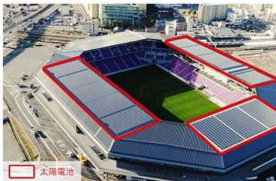
京都スタジアム 太陽光発電所
