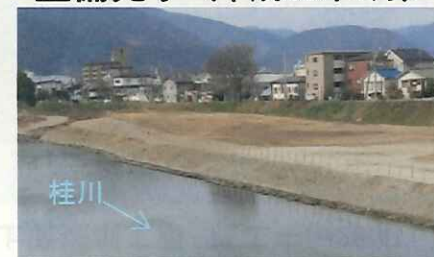
整備完了（平成28年1月）
