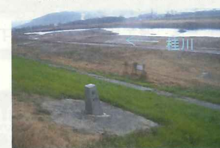
整備完了（平成28年1月）
