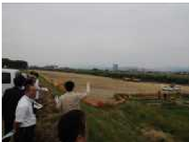
③久我地区河道掘削工事現場（竹林伐木除根等）
