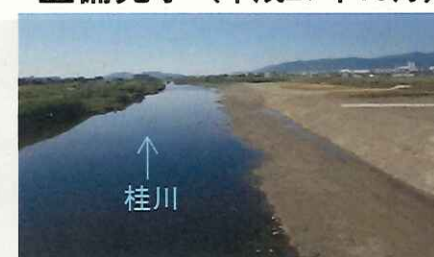
整備完了（平成27年10月）
