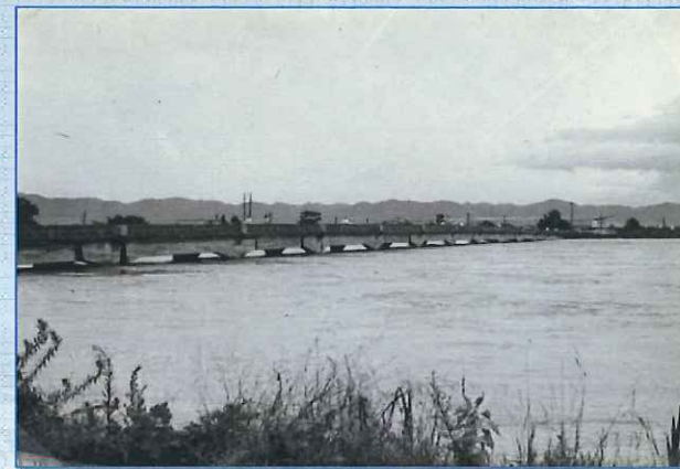
伏見区宮前橋付近の現地写真
