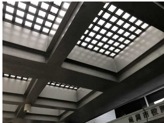
▲パーゴラの天井部分（ガラスブロック）のシーリングが劣化し、雨漏りの原因になっている。
