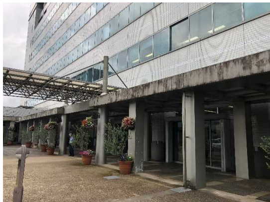
▲庁舎正面玄関のパーゴラの状況。
