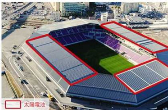
京都スタジアム 太陽光発電所
