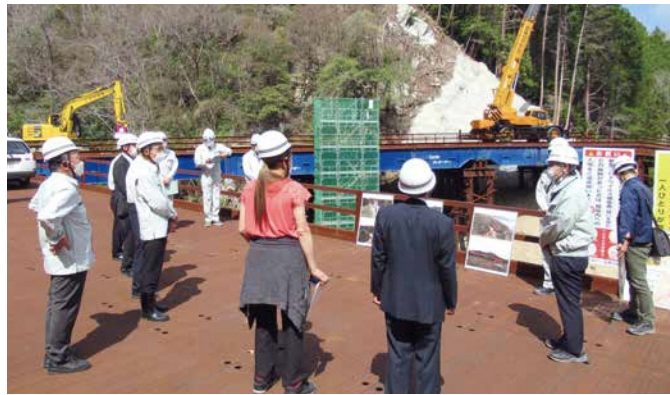
市内現地視察（国道 423 号バイパス工事の状況）
